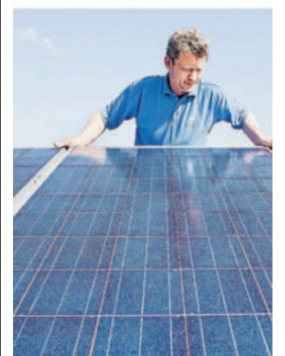
Techniker Steffen Kurz kontrollierte eine Photovoltaik-Anlage. FOTO: DPA
